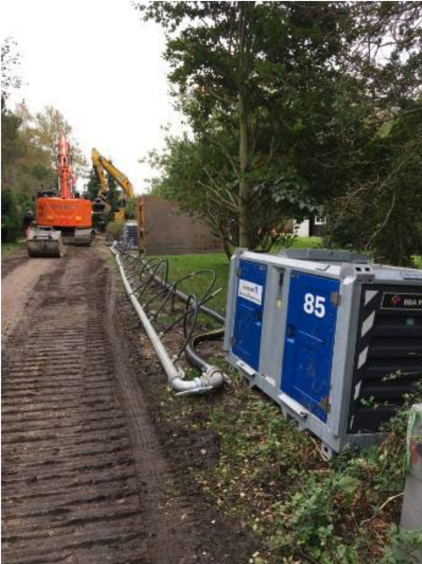
Billede af sugespidsanlæg.
